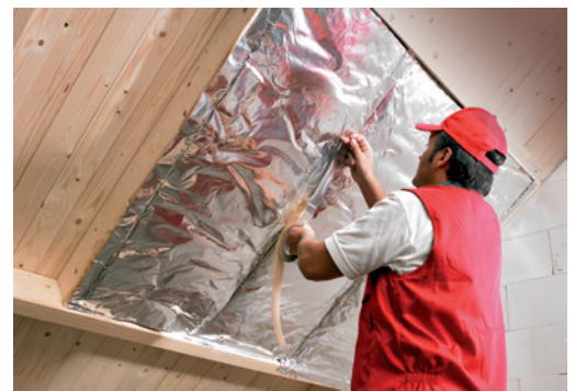
Luchtdicht afkleven van flensdeken. Foto: Rockwool
