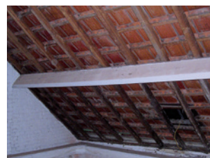
Niet-geïsoleerd keperdak zonder onderdak.
