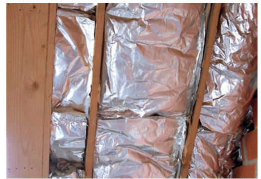
Verkeerd geplaatste spijkerflensdeken. Foto: Rockwool
