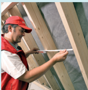
Isoleren zonder materiaalverlies met driehoekige platen. Foto's: Rockwool
