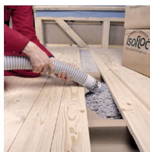
Zoldervloer isoleren tussen de draagstructuur met papiervloeken. Foto: isofloc
