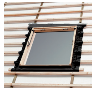
Onderdakdraag bij dakvlakraam. Foto: Velux
