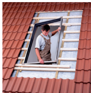
Plaatsing van een isolerend kader. Foto: Velux
