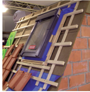
Winddicht afkleven ter hoogte van het dakraam.
