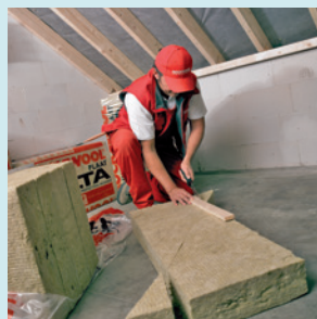
Isoleren zonder materiaalverlies met driehoekige platen. Foto's: Rockwool
