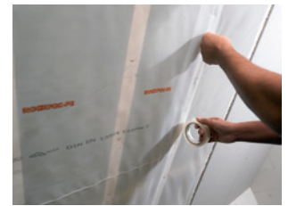
Afkleven van het luchtschermbaan. Foto's: Rockwool
