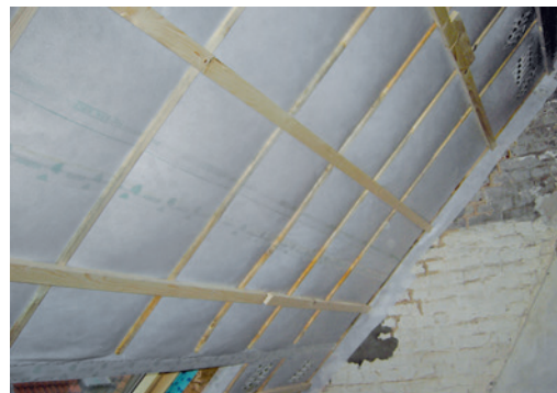
Luchtdicht afgewerkt hellend dak. Foto: E-advies
