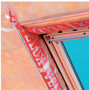
Dakvlakraam met de dampschermkraag. Foto: Velux
