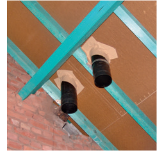
Winddicht afkleven van dakdoorvoeren.
