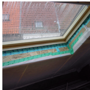
Luchtdicht afklevan ter hoogte van het dakvlakraam. Foto: E-advies
