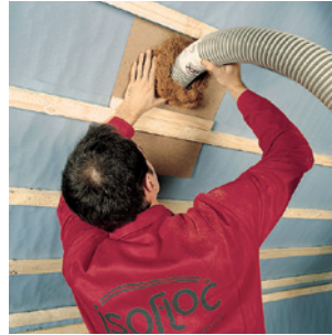
Inblazen papervlokken in een hellend dak. Foto: isofloc
