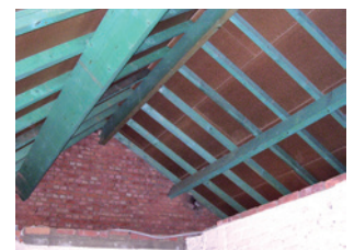
Niet-geïsoleerd keperdak met onderdak.
