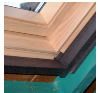
Dakvlakraam met isolerend kader.
