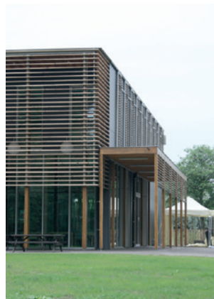
Een dakoversteek houdt de hoogstaande zon tegen. Verticaal geplaatste lamellen zijn geschikt voor oostelijk of westelijk georiënteerde ramen.
