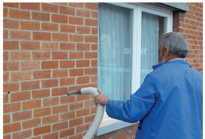
Via de openingen die men maakt in de voegen wordt het isolatiemateriaal ingeblazen. Bron: Knauf
